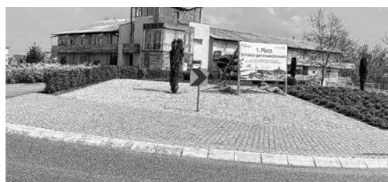
Kreisverkehr an der Altdorfer Kreuzung
